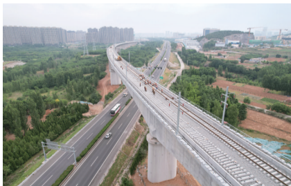
铺轨施工现场
