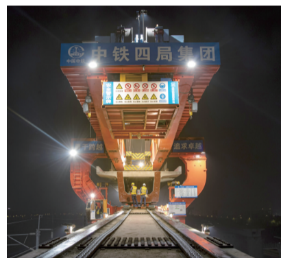
▼现场管理人员盯控架桥机喂梁作业
