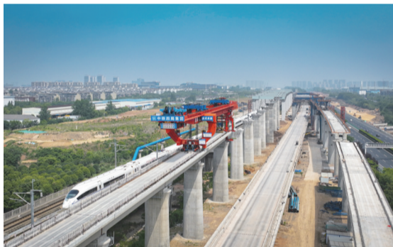
▲南沿江铁路上跨宁杭高铁架梁现场
