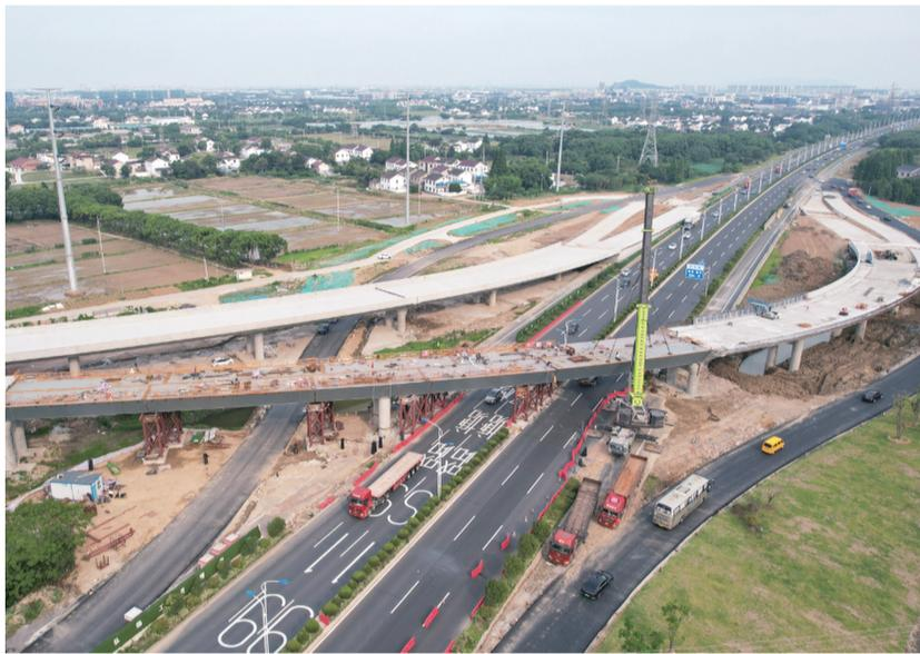
6月27日,中铁四局二公司施工的张家港东三环新建工程项目(张杨公路—苏虞张公路)苏虞张公路互通匝道桥最后一块大跨度钢箱梁吊装合龙。
