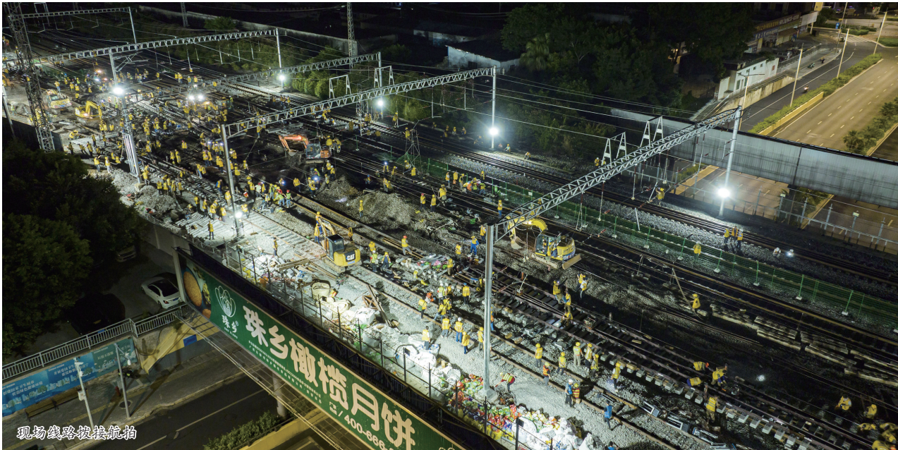
▲接触网改造与线路拨接施工同步进行 ▼标高测量作业
