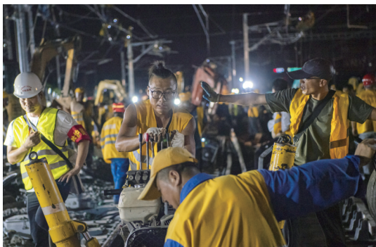
▲工人们相互配合完成道岔平移作业
