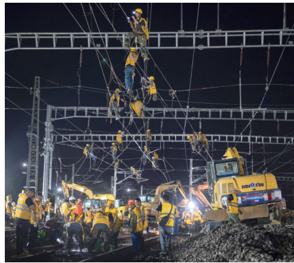
▲接触网改造与线路拨接施工同步进行 ▼标高测量作业
