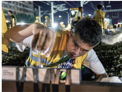
▲接触网改造与线路拨接施工同步进行 ▼标高测量作业
