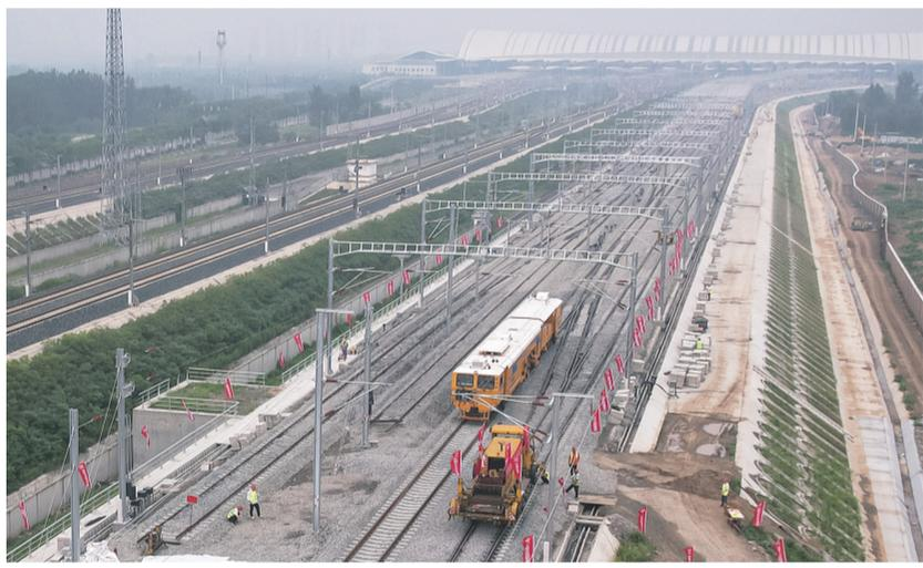
6月30日,全国首条市域高铁——济(南)莱(芜)高铁全线铺轨贯通。下一步,将全力推进以牵引供电、通信、信号、电力四电集成的施工以及站房建设为主的站后工程。济莱高铁起于济南东站,经历城区、高新区、章丘区、莱芜区、莱芜高新区、钢城区,终于钢城站,正线全长117.49公里。设济南东、历城、章丘南、雪野、莱芜北、钢城6座车站,设计时速350公里。中铁四局八分公司济莱高铁项目部主要负责长轨铺设、道岔铺设、轨道板铺设等有砟、无砟轨道施工任务。(吴怀球 吴秋枫 摄)
