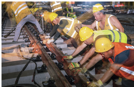
▲齐心协力完成道岔平移作业
