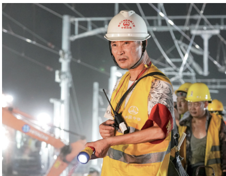
▲防护员盯控现场施工作业
