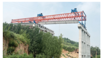
架梁现场 (杨元龙 摄)
