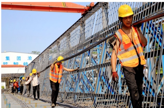
▲抬运长32米箱梁底板钢筋
