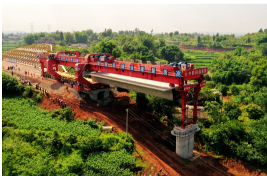
▲宜宾境内首孔梁架设
