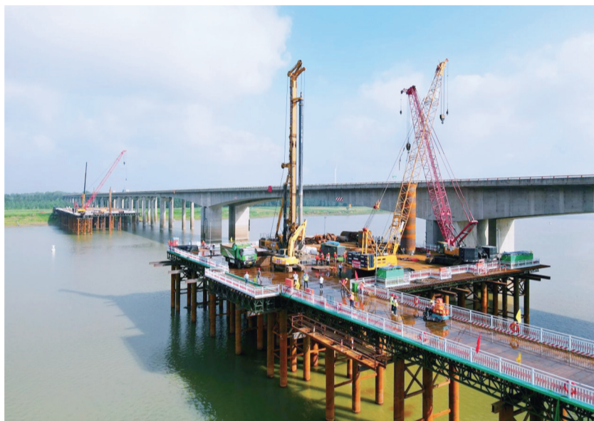
7月18日,中铁四局一公司承建的G36宁(南京)洛(阳)高速公路明光至蚌埠段改扩建工程TJ-03标准河特大桥主墩首桩开钻,进入主体施工阶段。淮河特大桥全长9公里,桥塔身高度达148.6米,精度要求高,是全线重点控制性工程,共有桩基44根。(白兴涛 摄)
