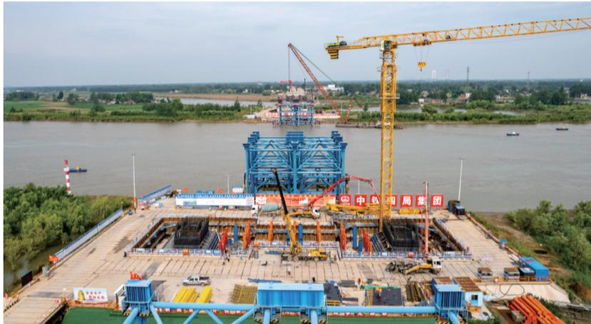
7月20日,中铁四局四公司承建的巢(湖)马(鞍山)城际铁路长江副汉航道桥首个主塔塔座浇筑完成,标志着主塔施工开始。
