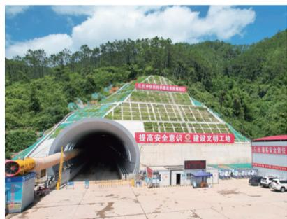
7月23日,中铁四局五公司南(宁)深(圳)铁路广西段最长隧道容岑隧道掘进突破4000米。容岑隧道为南深铁路广西段控制性工程,设计为双线单洞,全长7036米,为先期开工段的主体部分。
