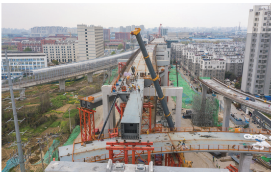
▲钢箱梁吊装作业
