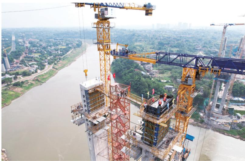
7月28日,由中铁四局二公司承建的渝(重庆)昆(明)高铁川渝段控制性工程——泸州沱江特大桥主塔封顶,标志着该桥进入斜拉索施工阶段。
