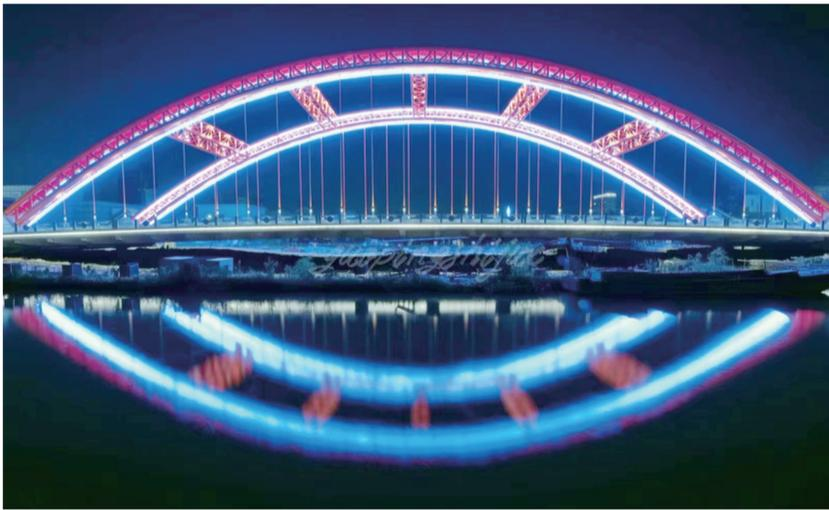
7月29日,中铁四局二公司承建的金柯桥大道轻纺城大桥建成通车。新建轻纺城大桥采用(16+144+16)米钢管混凝土系杆拱桥跨越萧绍运河,桥宽41米,全长177.4米。设计范围全长552.379米,道路等级为城市主干路,设计时速50公里,由原来的双向4车道改为双向6车道,增设一个地下通道。
