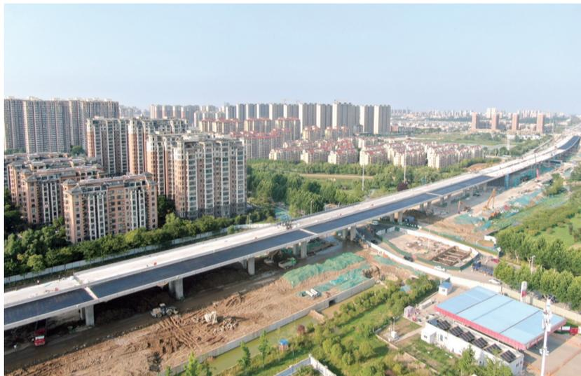
7月30日,中铁四局南京分公司承建的宿迁北京路快速化改造工程1标完成最后一联现浇箱梁浇筑,标志着项目高架桥桥梁主体结构全部完工。
