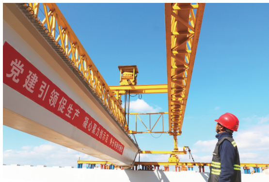
▲公路箱梁架设
