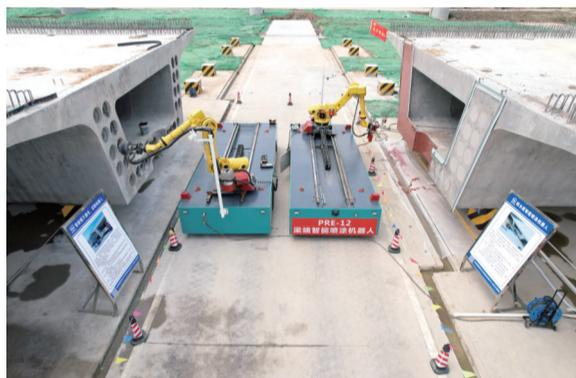
▲箱梁智能雷毛及钢绞线切割机器人
