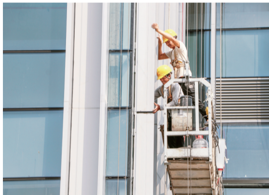
▲幕墙安装施工
