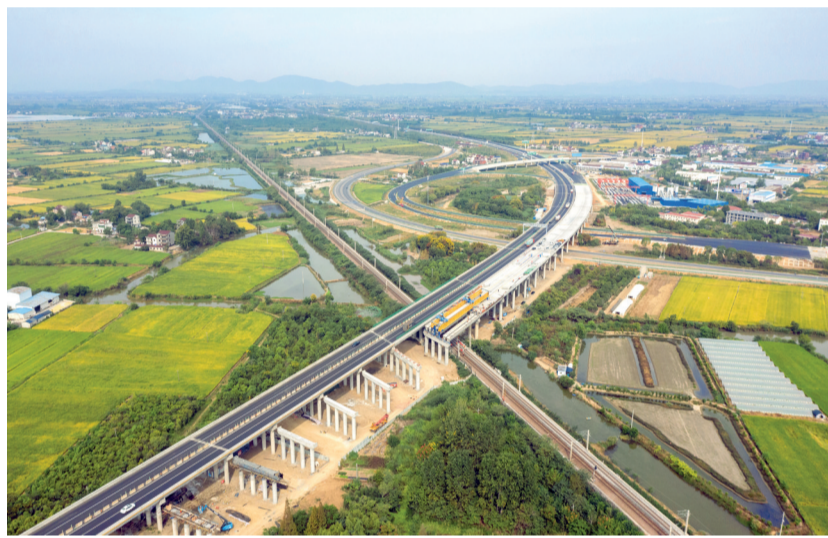
9月23日,中铁四局四公司承建的芜(湖)合(肥)高速公路上跨淮南铁路立交改扩建工程上跨淮南铁路箱梁架设完成。芜合高速公路是安徽省通往沿海经济发达地区的重要干线公路。上跨淮南铁路立交改扩建工程位于芜湖北互通内,长1101米,其中涉铁段总长112米,与淮南铁路交叉夹角为133.1°,采用40米跨径预制组合箱梁斜交布置跨越铁路,共需架设箱梁518片,其中4次跨淮南铁路,采用Ⅱ级封锁营业线施工。(苏诗洋 丁姍 摄)
