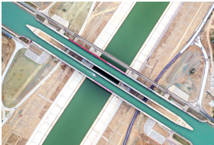
9月23日下午3时30分,一艘7米长的船舶驶过引江济淮淝河总干渠钢渡槽,标志着由中铁四局承建的世界最大跨度通航钢渡槽——引江济淮淝河总干渠钢渡槽通航。
