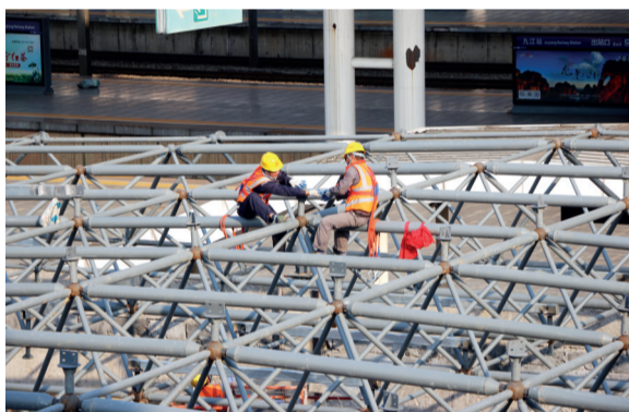
▲候车厅钢网架安装
