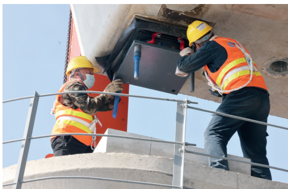
▲安装支座板螺栓
