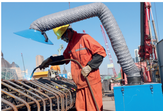
▲焊烟收集器对焊接钢筋产生的烟尘进行收集
