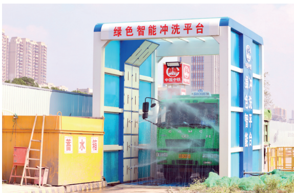
▲智能冲洗平台对渣土运输车辆进行冲洗
