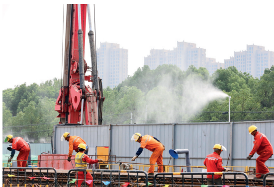
▲高杆喷淋、湿法作业确保施工现场不扬尘
