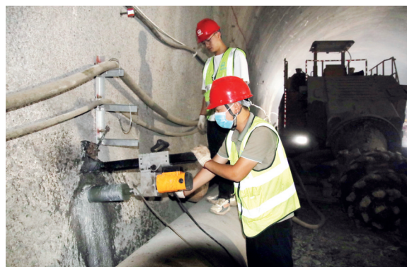
▲试验人员进行隧道取芯
