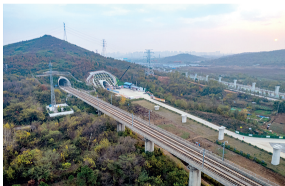
▲新大金山隧道出口
