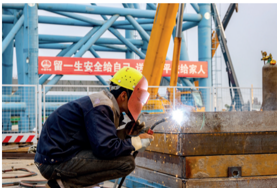
▲模板焊接作业
