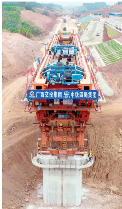
▲准备落梁 ▼安装顶梁油顶油管
