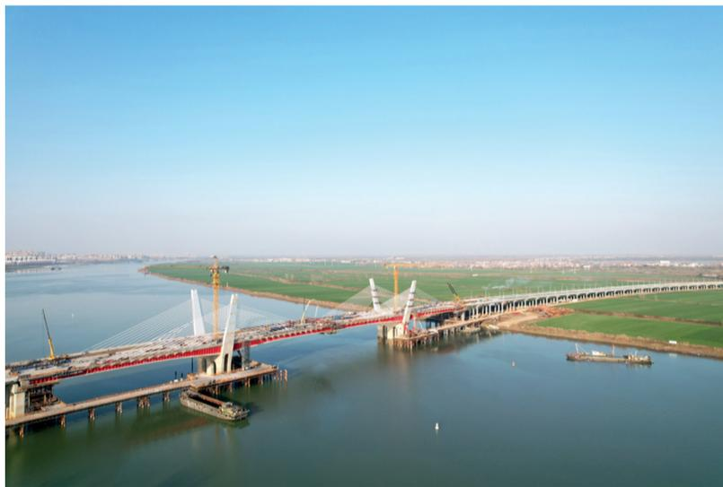
12月5日，中铁四局市政公司承建的蚌埠五河S313县道淮河特大桥中跨合龙。蚌埠五河S313县道淮河特大桥长2017米、宽35.5米，共计53跨，是国内首座单箱五室双侧斜腹板桥梁，也是安徽省首座波形钢板PC组合箱梁矮塔斜拉桥。建成后，将提高区域道路的整体通行能力，改善跨河交通条件，优化和完善区域路网结构，促进皖东北经济社会健康发展和五河县旅游资源的全面开发。(陈继敏 许程涵 摄)
