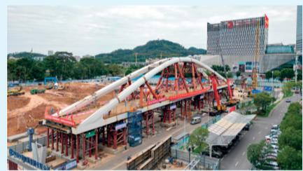
本报东莞讯 12月5日，中铁四局五公司承建的东莞市中心核心区立体慢行系统2号桥上跨东莞大道钢箱梁开始顶推施工。
