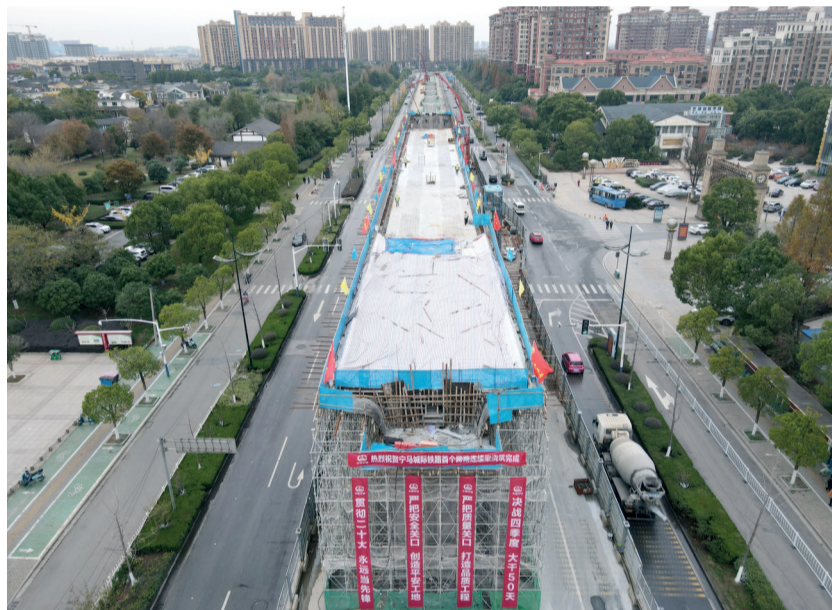
12月1日,中铁四局一公司施工的宁(南京)马(鞍山)城际铁路跨桥山路支架现浇连续梁A1标段浇筑,标志着宁马城际首个跨路连续梁施工完成。宁马城际铁路是马鞍山市推动宁马同城化的战略性先导工程,全长约54.23公里。建成通车后,南京、马鞍山中心城区仅需30分钟即可互通互达,对推动马鞍山全面对接长三角具有重大战略意义。其中,中铁四局管段长19.72公里,施工内容为桥梁、箱梁预制、路基、车站等。(谷敏 崔柯 摄)
