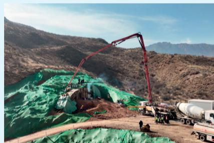
本报碌曲讯 12月11日,中铁四局西(宁)成(都)高速铁路甘肃段1标项目部(七分公司)格尔隧道出口导向墙浇筑完成。
