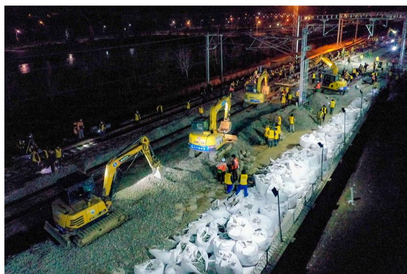
12月15日凌晨4时,经过200余人5小时紧张有序施工,中铁四局八分公司承担的莱(西)荣(成)高速铁路荣成站北咽喉区站改工程第二次Ⅱ级封锁施工完成。此次站改封锁施工内容包括临时栅栏拆除及恢复、轨料倒运、线路拆除、道岔插铺、铝热焊接、绝缘施工、道岔捣固、配砟整形、临时车档设置等。莱荣高速铁路是山东省“四横六纵三环”高速铁路网重要组成部分,正线全长192.814公里,设计时速350公里。八分公司承担莱荣铁路380公里铺轨、站前工程2标666榀箱梁架设、46公里无砟道板铺设和荣成站改造的施工任务。(王学荣 韩玉江 王振国 摄)
