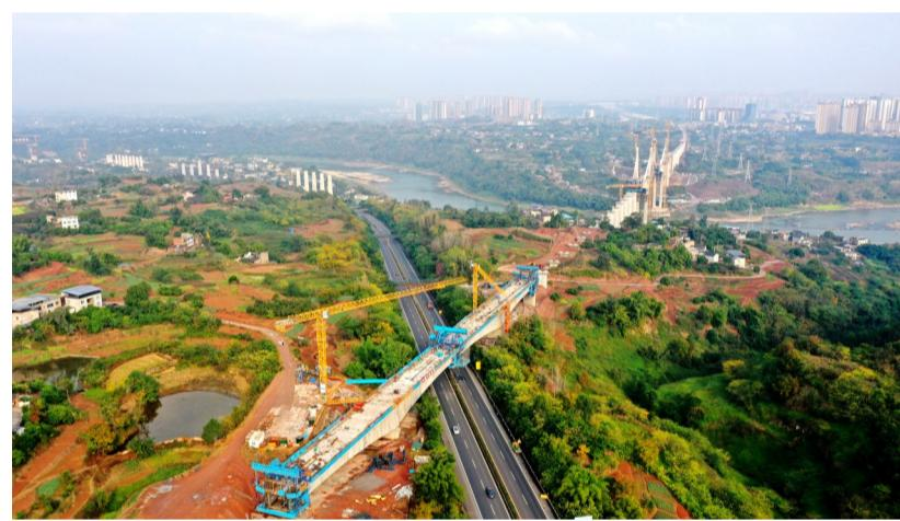
12月14日,中铁四局二公司渝(重庆)昆(明)高速铁路川渝段4标项目部(二公司代局指)泸州沱江特大桥跨厦蓉高速公路连续梁合龙。泸州沱江特大桥长2613.315米,其连续梁为单箱单室、直腹板、变截面结构,采用纵向预应力预应力体系,长273.6米,因其上跨厦蓉高速公路,高空作业多、安全风险高、施工难度大。渝昆高铁是国家八纵八横高速铁路网主通道之一京昆通道的重要组成部分,建成通车后,有利于完善国家综合立体交通网,大幅压缩重庆至昆明的时空距离,将为长江经济带发展提供有力支撑。
