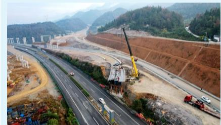
本报重庆讯 12月17日,由中铁四局六公司承建的渝(重庆)湘(长沙)复线高速公路巴彭5标水江北互通立交跨包茂高速公路E匝道2号桥钢箱梁第四节段开始架设。
