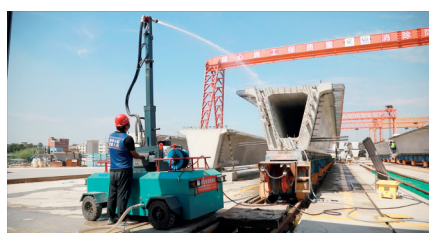
箱梁内箱及顶板养护智能台车
