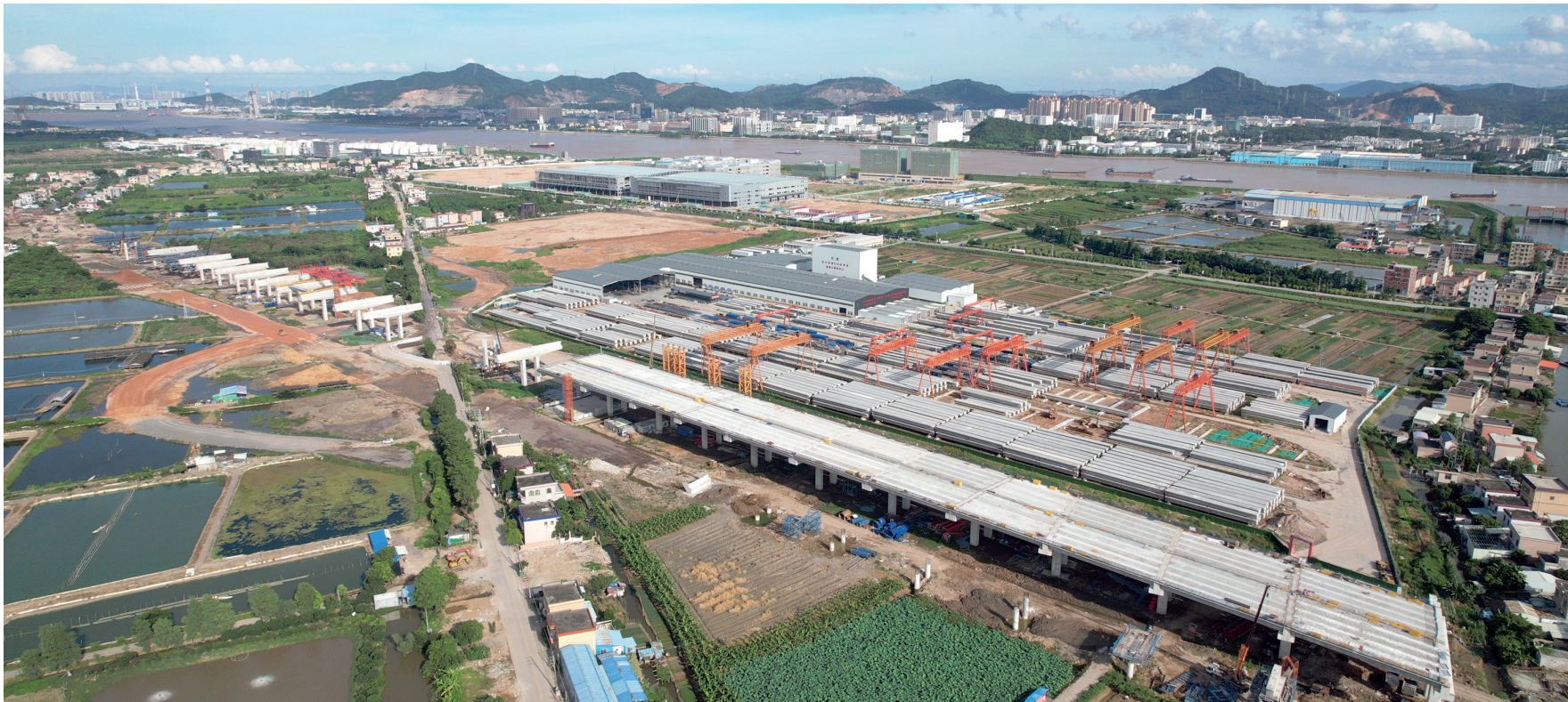
建设中的南中高速公路制梁生产区
