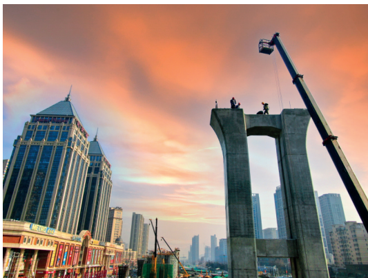
▲墩柱垫石施工
