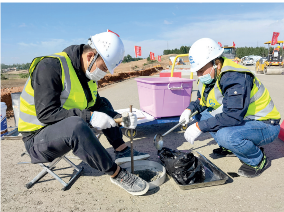
检测水稳基层压实度
