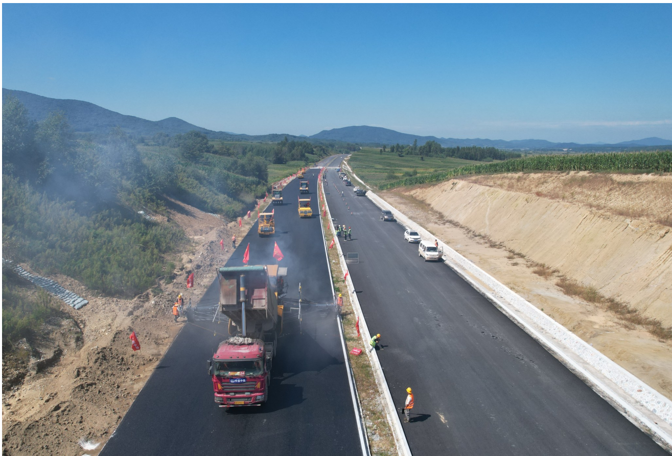
主线左幅路面施工
