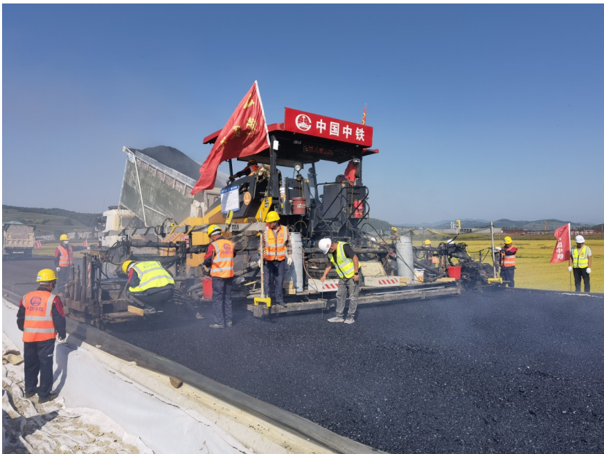
沥青路面下面层摊铺施工
