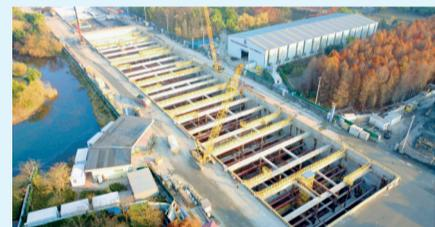
本报上海讯 1月1日,中铁四局上海公司承建的上海轨道交通市域线机场联络线工程张江站主体结构封底。
