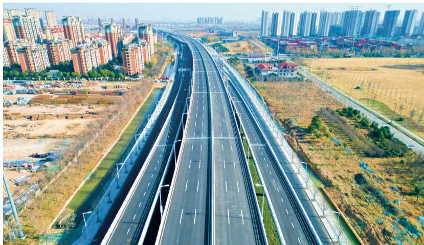
本报宿迁讯 1月3日,中铁四局南京分公司参建的宿迁北京路快速化改造工程建成通车。北京路快速化改造工程设计为主线双向6车道,时速80公里,辅路双向4车道,时速50公里,全长11.51公里。南京分公司负责施工的BJL-SG1标段全长4.05公里,施工内容为主线高架桥、地面辅路。该工程是宿迁市快速路网“二环十射”中内环的南环,也是中心城市各片区与外围高速公路快速衔接的重要通道,创造了宿迁建设史上投资规模最大、涉及面最广、施工综合难度最高、施工周期最短等多项纪录。
