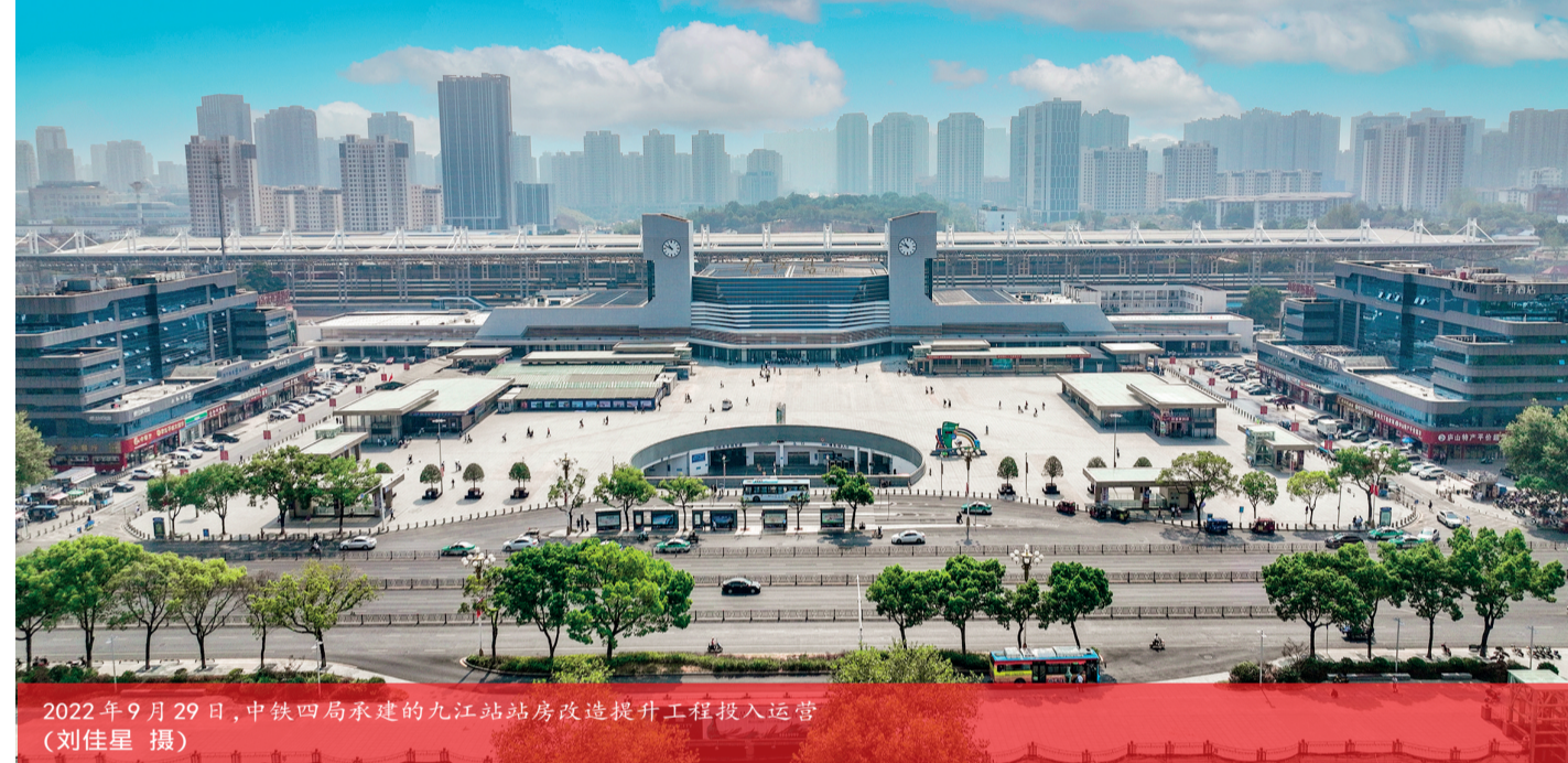
2022年9月29日,中铁四局承建的九江站站房改造提升工程投入运营
