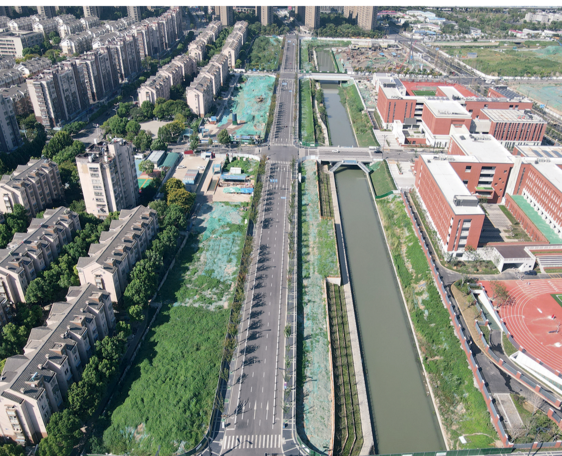
2022年9月1日,上海公司参建的南京南部新城汇景西路、汇景东路、柴园北路、佳营路建成通车
