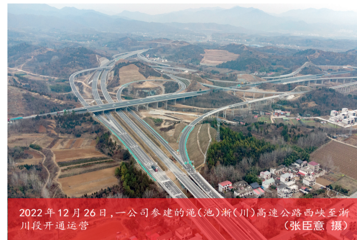
2022年12月26日,一公司参建的沔(池)浙(川)高速公路西峡至浙川段开通运营
