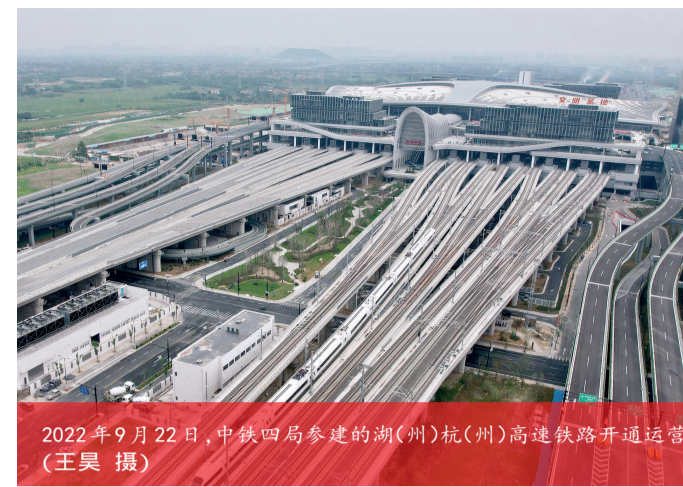
2022年9月22日,中铁四局参建的湖(州)杭(州)高速铁路开通运营
