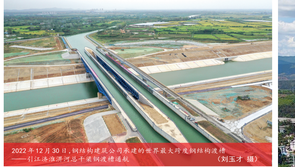
2022年12月30日,钢结构建筑公司承建的世界最大跨度钢结构渡槽——引济淮济河总干渠钢渡槽通航
