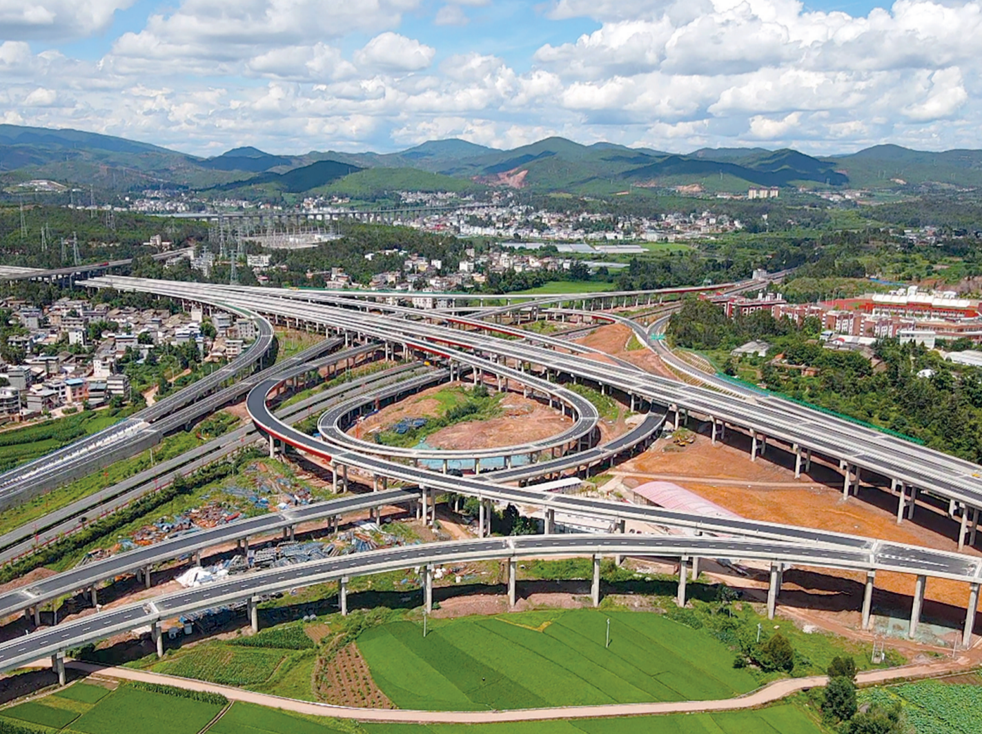
2022年8月26日,安装公司参建的玉(溪)楚(雄)高速公路开通运营
