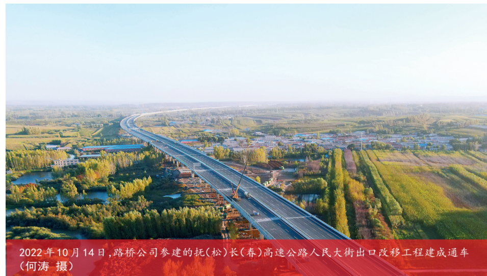
2022年10月14日,路桥公司参建的抚(松)长(春)高速公路人民大街出口改移工程建成通车
