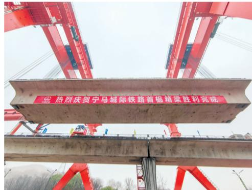
2月9日15时许,由中国中铁(上海)投资集团有限公司投资、中铁四局承建的宁(南京)马(鞍山)城际铁路全线首孔箱梁成功架设,标志着宁马城际铁路进入桥梁上部施工阶段。
