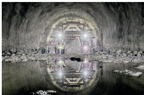
▲容岑隧道开挖断面
