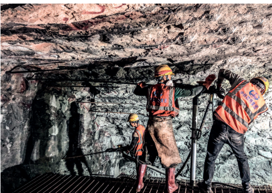
▲工人正在钻药孔
