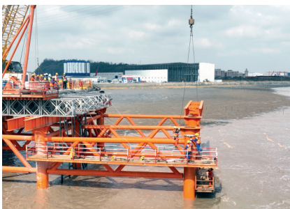
▲钢栈桥桩帽安装
