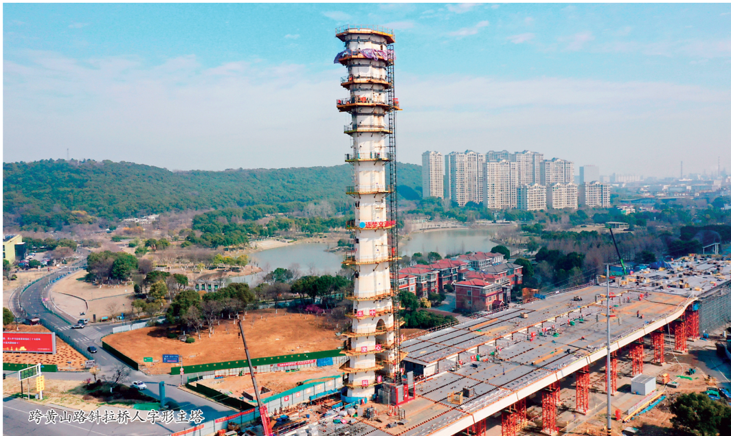
吊装“人”字形主塔最后三个节段
