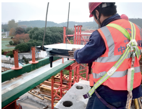
▲精轧螺纹钢螺帽紧固
