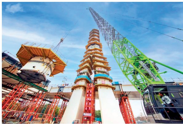
吊装“人”字形主塔最后三个节段
