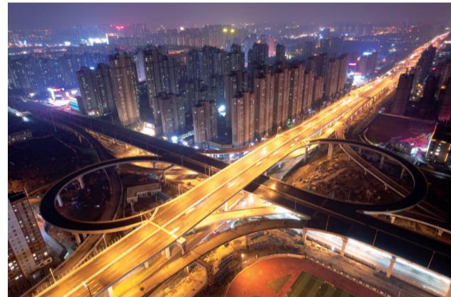
2月24日,中铁四局钢结构建筑公司参建的包公大道3标最后一片钢箱梁吊装完成。包公大道(二十埠河至龙兴大道)快速化改造工程全长约15.5公里。钢结构建筑公司参建的3标主要负责包公大道与桥头集路交叉口的22联匝道桥钢箱梁的加工、运输、架设、涂装、支座安装,钢箱梁共重13664吨。
