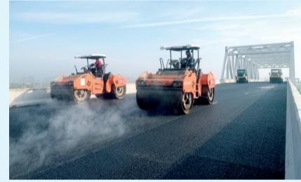
**本报宿迁讯** 2月23日，中铁四局二公司承建的宿连航道桥梁1标宿沭路大桥主线沥青铺装完成。
