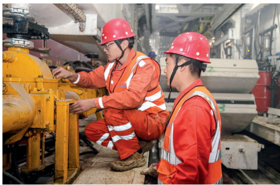
▲同步注浆泵设备检修
