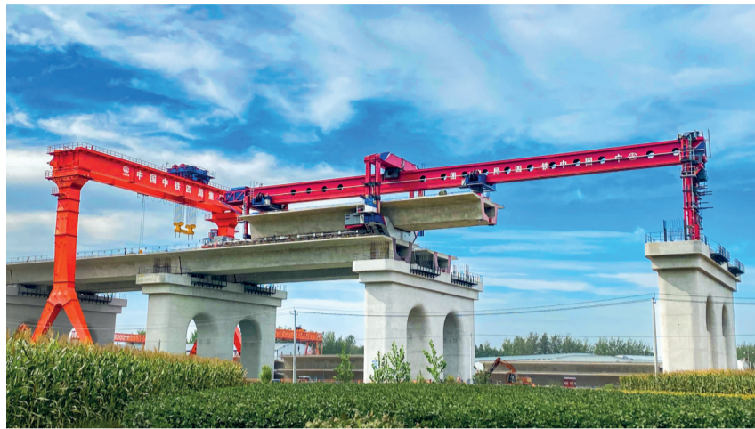
JQBS1100型架桥机正在喂梁作业
