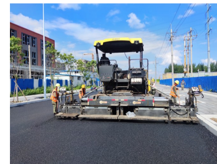
抚改革创新示范区项目路面摊铺
