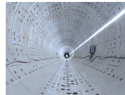
沈阳地铁2号线南延线项目盾构区间
