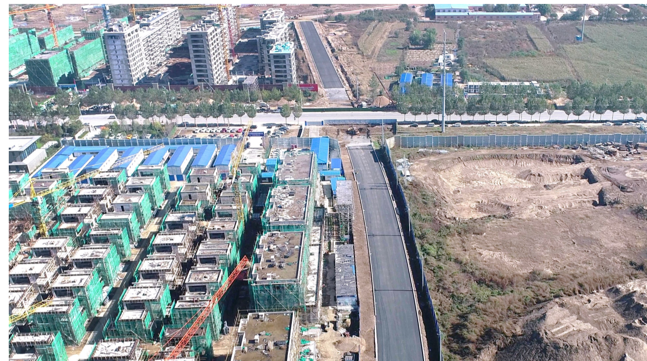
沈抚示范区EPC项目
