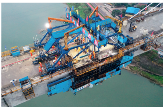
▲合龙段混凝土浇筑
