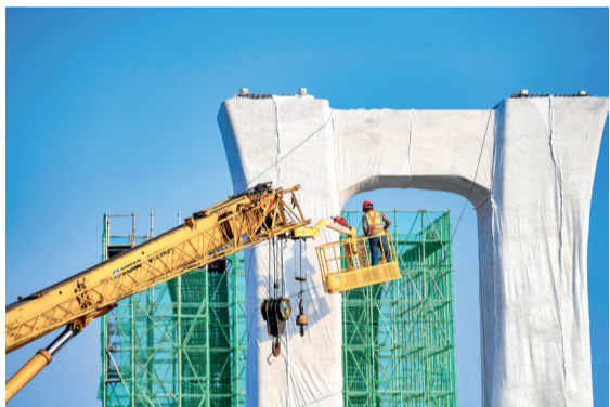
▲墩身养护施工
