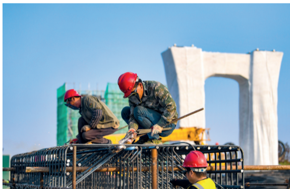
▲加工墩柱钢筋笼
