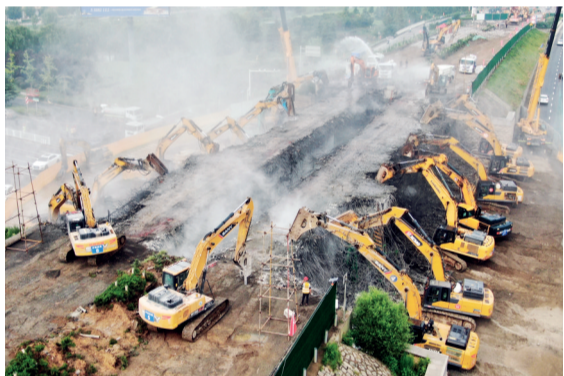
▲5小时拆除71.7米大桥
