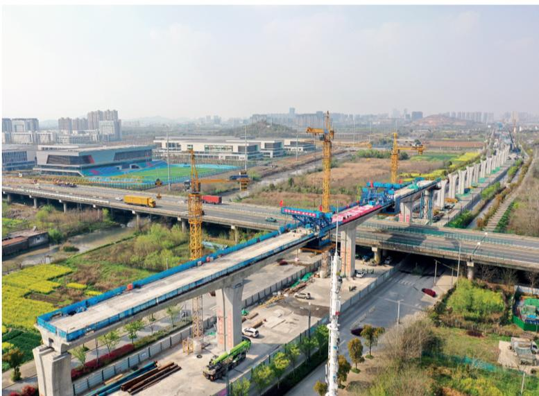
4月2日,由中铁四局一公司承建的宁(南京)马(鞍山)城际铁路(马鞍山段)跨常合高速公路刚构连续梁合龙。这是全线首个采用挂篮法施工完成合龙的连续梁。
