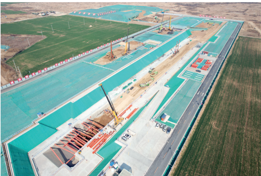
东西轴线主线施工现场航拍
