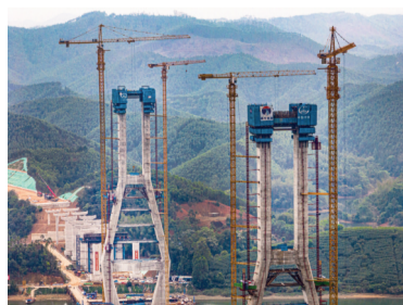
西津郁江特大桥主塔即将全面封顶
