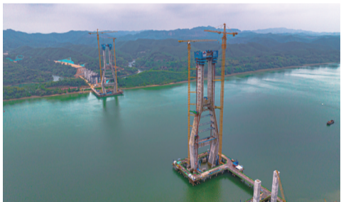
西津郁江特大桥主塔
