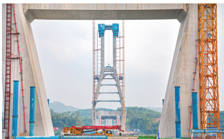
已建设至133米的西津郁江特大桥主塔
