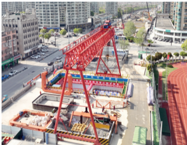
世界首例大断面矩形曲线顶管工程顶进现场
