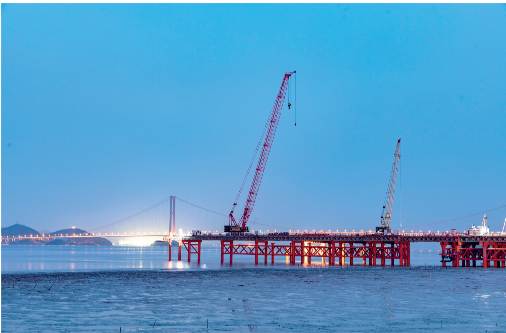
夜幕下的海上栈桥平台施工
