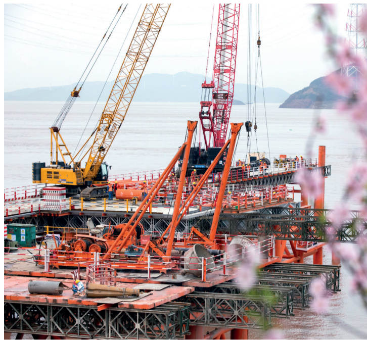
海上钻孔平台锚桩施工
