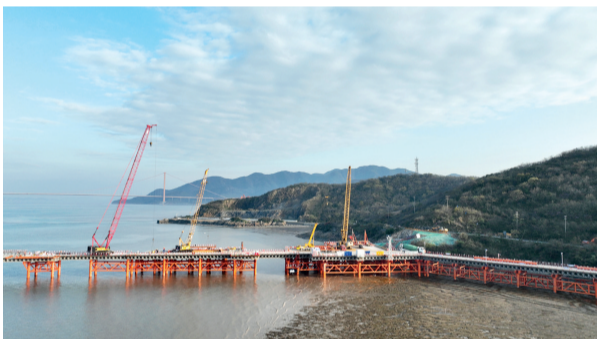
海上钻孔平台钢管桩施工
