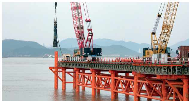
海上栈桥钢管桩液压冲击锥施打
