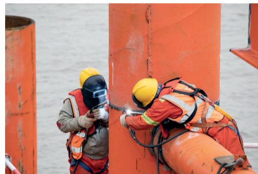
海上栈桥钢管桩焊接
